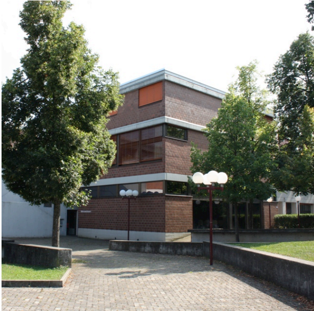
BLICK AUF EINGANGSITUATION UND HAUS 3
