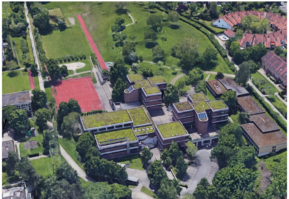
Luftaufnahme Schulanlage Buechwis
