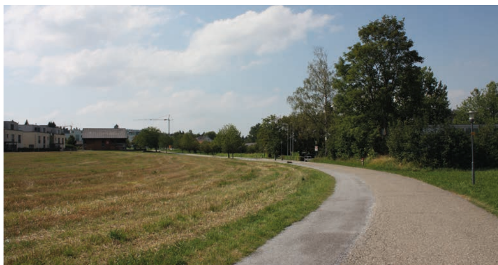
Zufahrtsstrasse Schulareal Bommern
